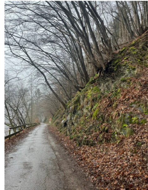
Abbildung 2: Blick auf einen Felsböschungsab-schnitt entlang des asphaltierten Seerandweges
