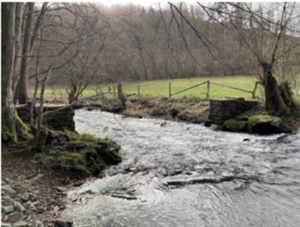
Abbildung 2: Situation an der Brücke "Mestrenger Mühle": Bäume sind direkt am alten Fundament gewachsen. Eine Wiederherstellung der Brücke und entnahme der alten Fundamente ist nur bei einer Entfernung der Bäume möglich (Foto: DOSER KEMPEN KRAUSE INGENIEURE GmbH).
