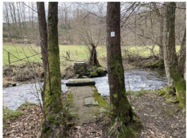
Abbildung 2: Situation an der Brücke "Mestrenger Mühle": Bäume sind direkt am alten Fundament gewachsen. Eine Wiederherstellung der Brücke und entnahme der alten Fundamente ist nur bei einer Entfernung der Bäume möglich (Foto: DOSER KEMPEN KRAUSE INGENIEURE GmbH).
